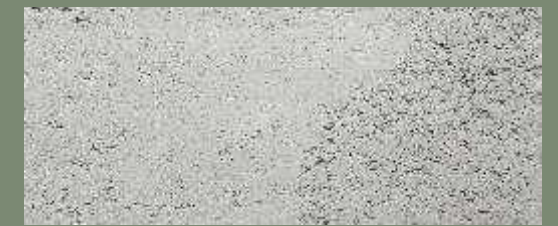
M-176 工業混凝土牆
